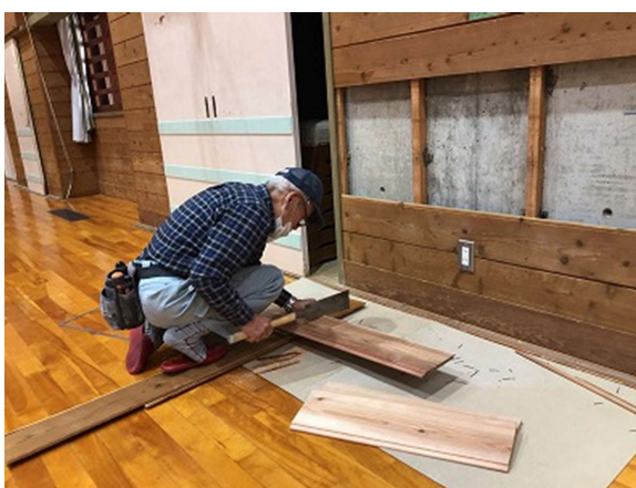
↑ 体育館の壁面の修繕
