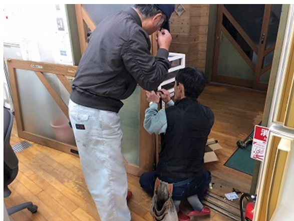
↑ 職員室の引き戸の戸車の修繕
